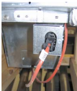
Afbeelding 6: Bevestig de twee-pens witte aansluitingen en steek de zwarte aansluiting in de doos zoals aangegeven. * Merk op dat de positie van de zwarte connector kan verschillen van de positie op de foto.
